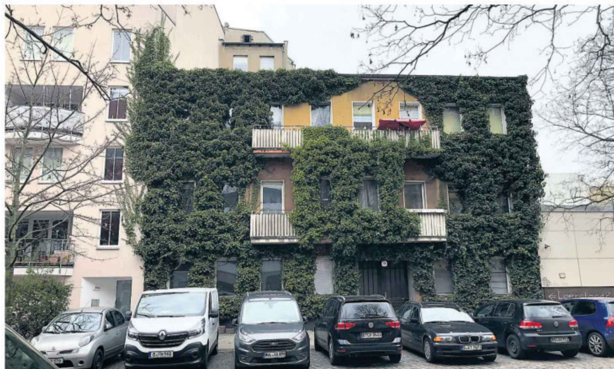
Das Vorderhaus in der Jagowstraße 35: Erst war die Aufstockung genehmigt worden, jetzt will der Eigentümer es lieber abreißen.
